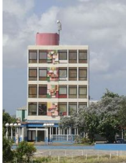
Edificio di SSK: Schouwburgweg 44.
